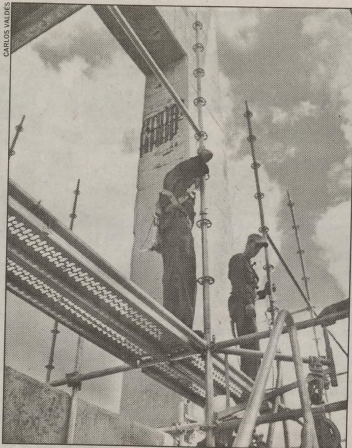
Los trabajos se realizan bajo condiciones extremas.
