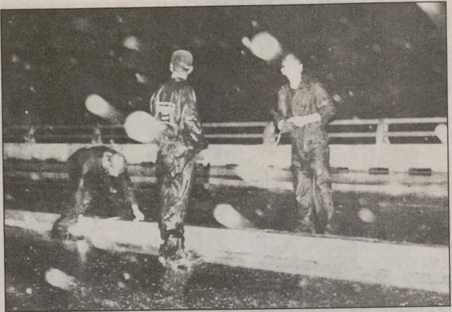
De madrugada y bajo lluvia concluyeron especialistas de la ENIA los estudios para dictaminar el estado del puente.
